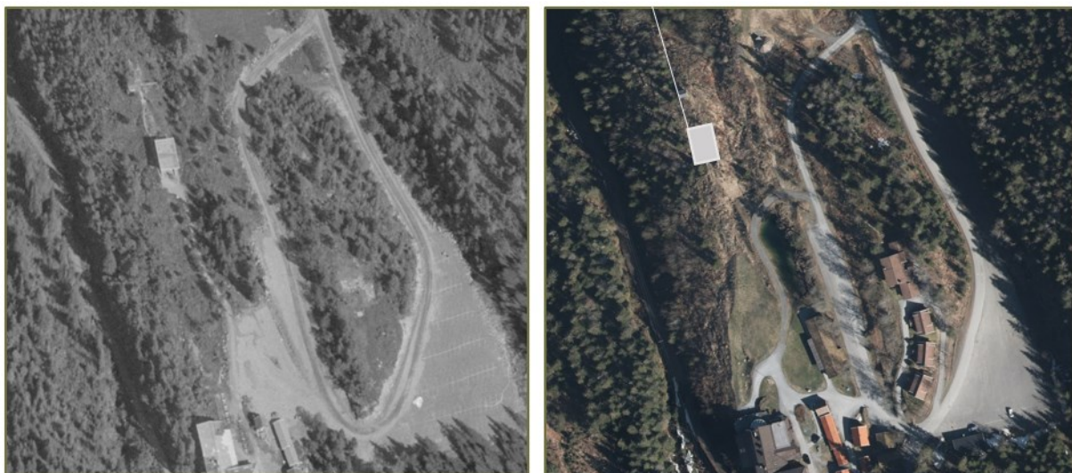
Figur 10: Flyfoto fra 1967 med heisbygg oppe ved endestasjon. Flyfoto fra 2020 med plassering av nedlagt heisbygg skissert
