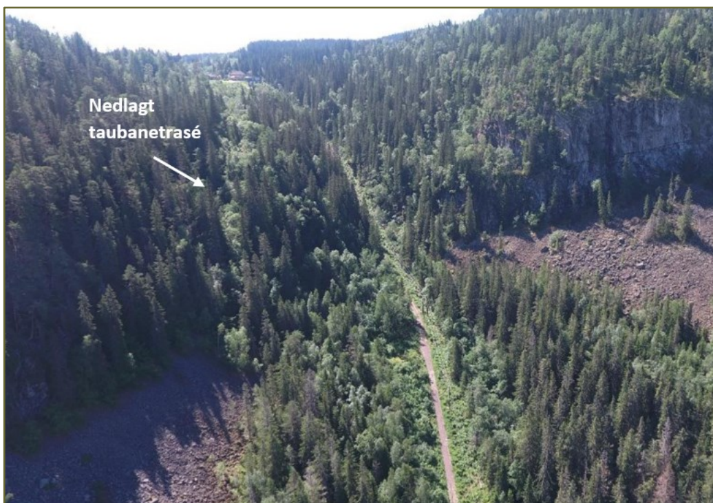
Figur 18: Dronebilde av Kleiva og Kleivstua. Kilde: Utredning av skredfare-Sundvollen, Rambøll 2023
