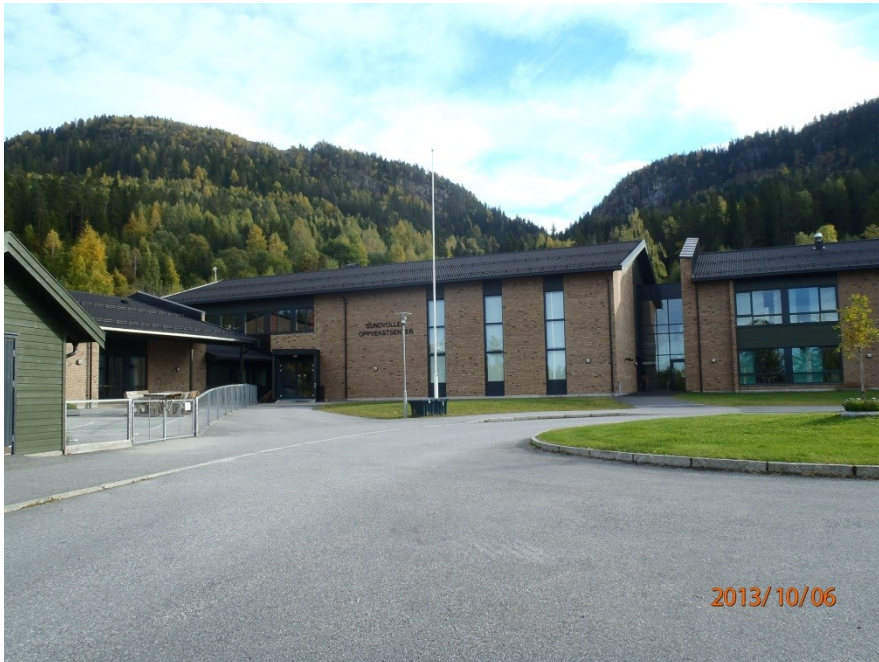
Figur 3-2. Sundvollen oppvekstsenter med Krokkleiva og Krokskogen bak.
