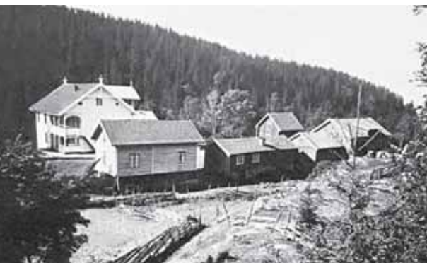
Kleivstua rundt 1910 – nærmest som en bondegård. Hovedbygningen ble ombygd til sveitserstil i 1890–91.
