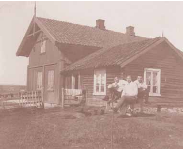
Enga cirka 1930. Våningshuset i to etasjer ble bygd i 1898, mens den gamle tommerstua (nærmest) var fra rundt 1800, og ble revet i 1960-årene.
