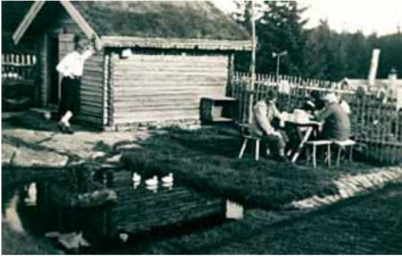
Den første hytta som Oskar Østmo bygde på Fjellsetra (i 1926). Den stod på løkka til Søgarden Leine, som eier hytta vi ser taket på til høyre. Legg merke til dammen med «ender» i forgrunnen.
