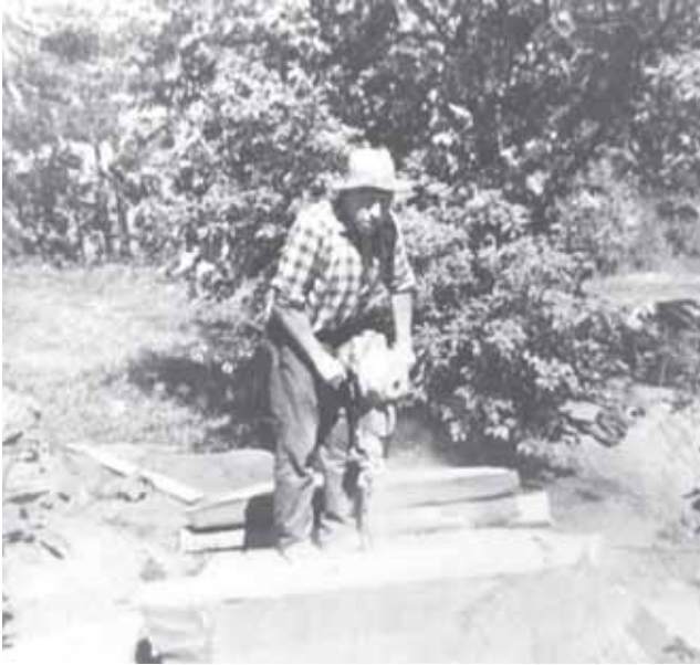
Martin Pedersen med boremaskin i hellebruddet i Korneliusbråten en gang rundt 1960.
