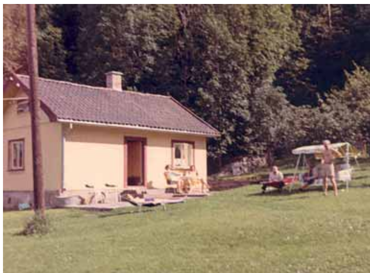
Den gamle stua i Korneliusbråten var fra 1800-tallet, og ble revet i 1995. Bildet er tatt i 1960-årene.
