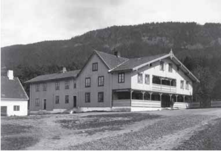
Hovedbygningen på Sundvolden ble påbygd en stor veranda i sveitserstil og en sidefløy i 1870-årene. Til venstre ser vi en del av steinfjøset.
