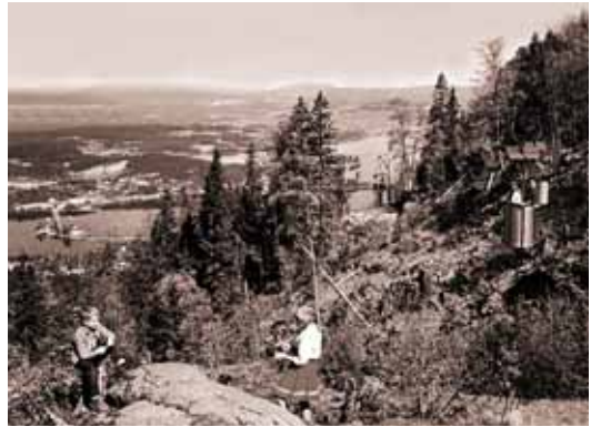
I 1958 ble den gamle stolheisen i Krokkleiva erstattet av en tønneheis. Den var i drift til 1977.
