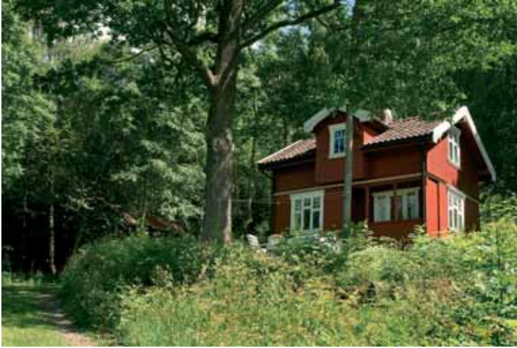
Det gamle våningshuset i «Øvre Lyse» fra 1906–07 ble renovert i 1994. © Fotograf Siri Berrefjord
