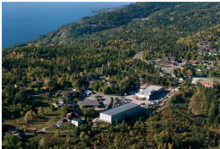
Søndre del av Sollihøgda tettsted, med industribyggene til Monterings-Service AS Norport. I bakgrunnen Holsfjorden.
