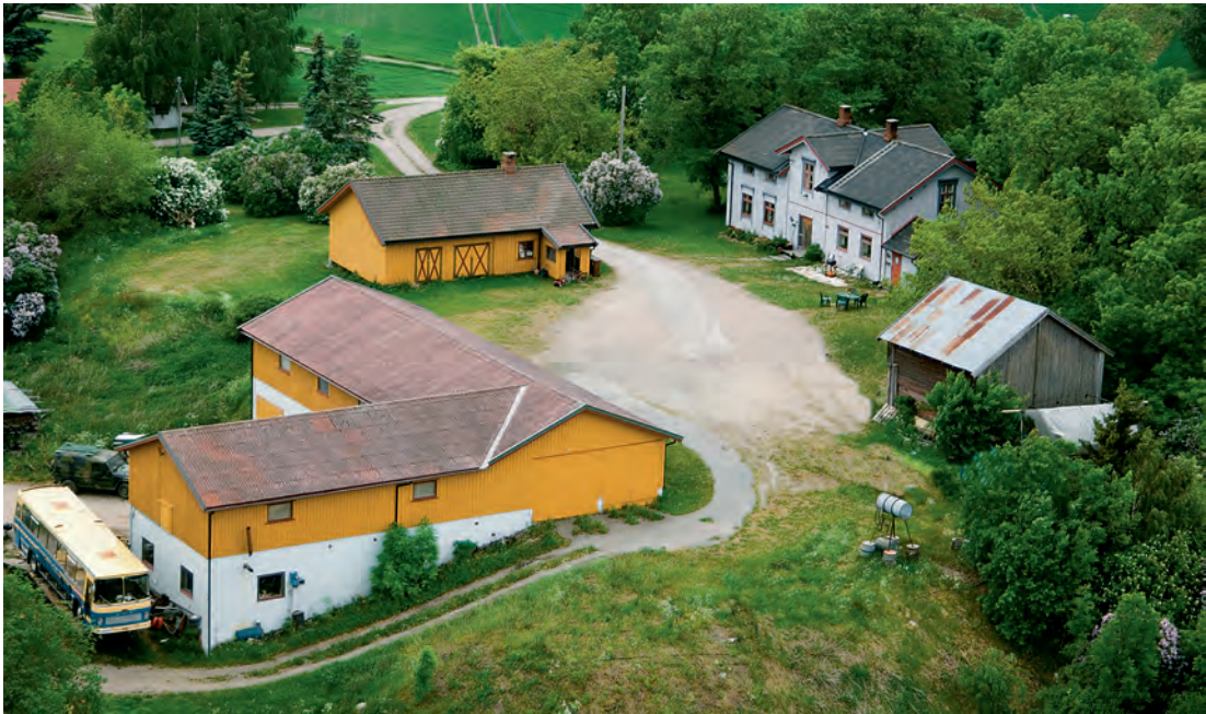
Øvre Svarstad i 2006. Hovedbygningen på gården består av to tommerhus fra sist på 1700-tallet, som ble bygd sammen cirka 1880.
