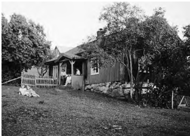
Gomnesbråten sist i 1940-årene. Våningshuset fra rundt 1850 ble revet i 1974.
