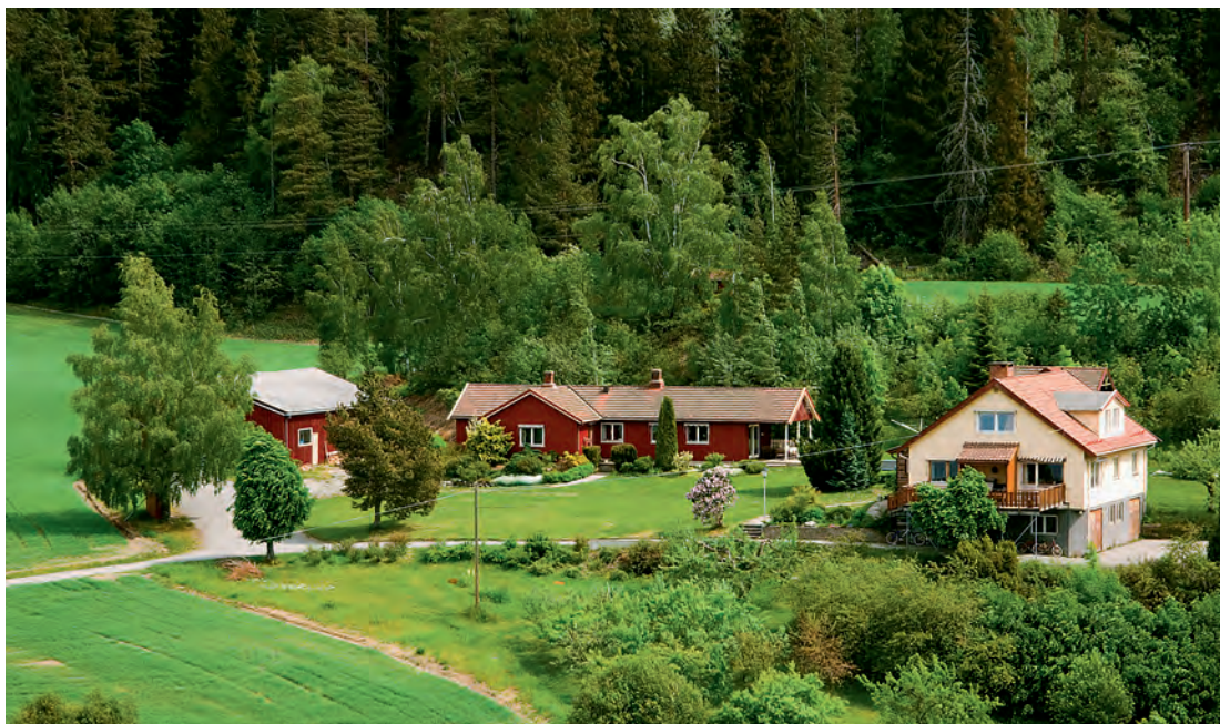
Jenseløkka (Gata) i 2006. Hovedbygningen (til høyre) ble bygd i 1958.
