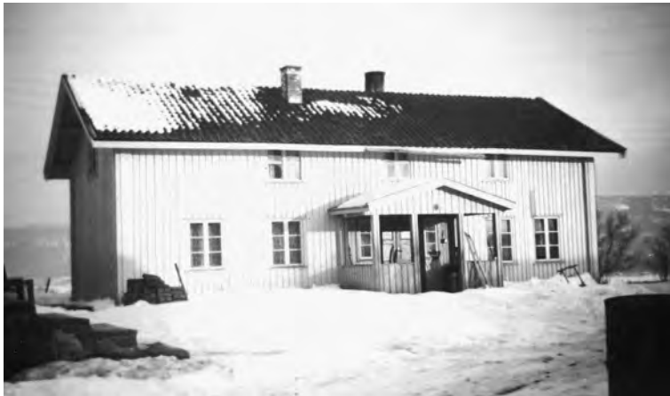
Hovedbygningen i «Lars» etter restaureringa i 1956.
