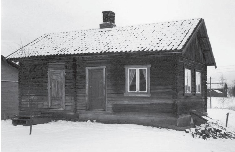
Gamlehuset i Selte er fra rundt 1850. Bildet er tatt etter at det ble flyttet over på ny grunnmur i 1975.
